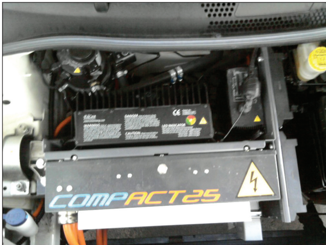
Elmotorn ligger under motorhuv, batterierna i aktern
