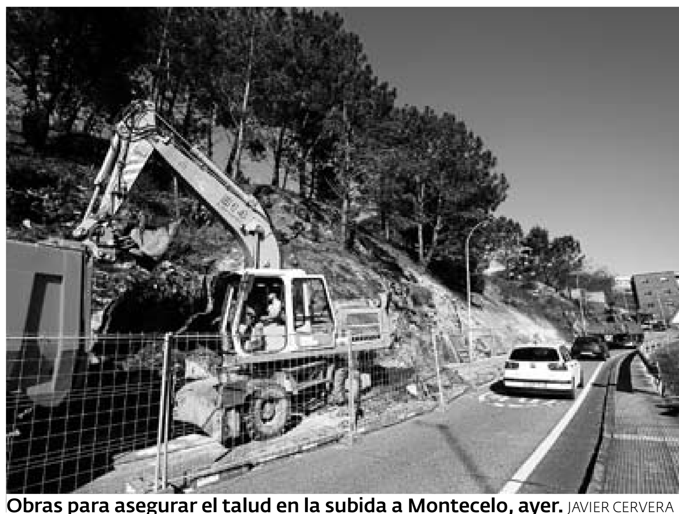
Obras para asegurar el talud en la subida a Montecelo, ayer. JAVIER CERVERA
